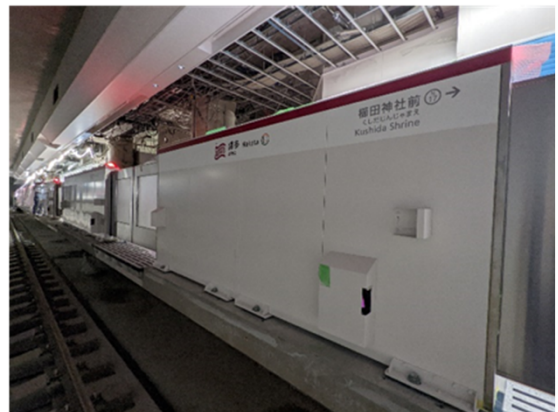
⑥地下駅舎部：プラットホームの進捗状況 (ホームドア工事)
